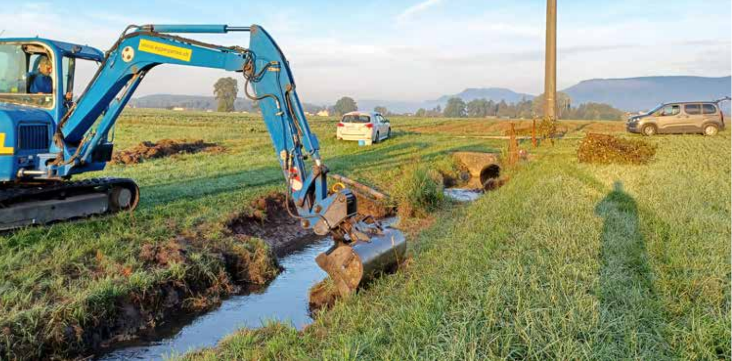
▲ Bagger im Einsatz. Aushub von total 26 Nischen.
